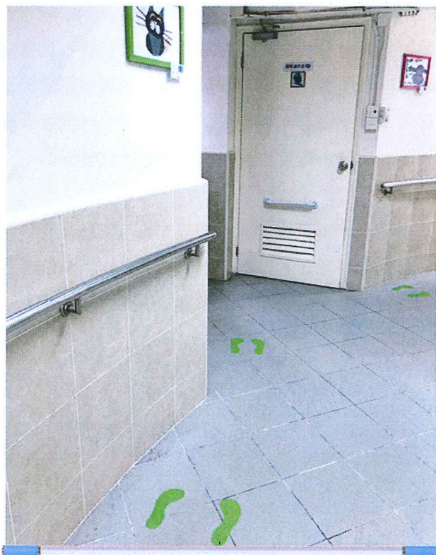
廁所門口加設站立指示
